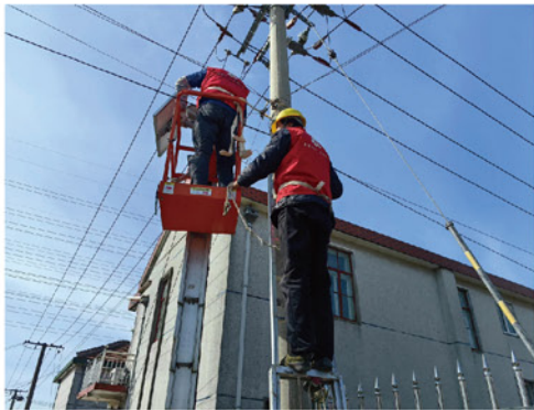
▲“点亮竖河”项目施工现场
