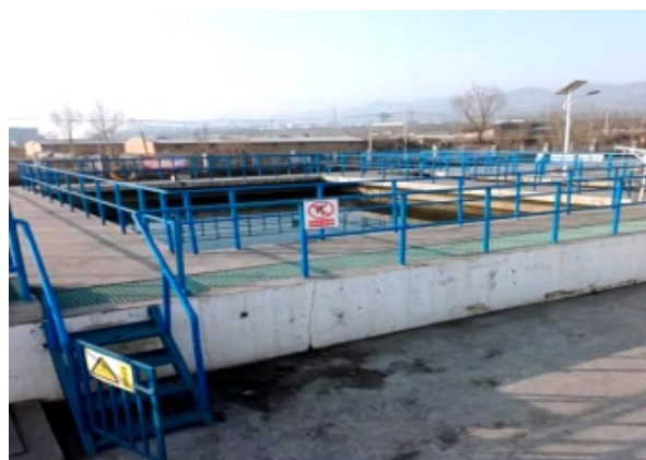
生活污水处理站
