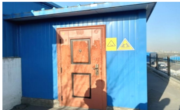
危废暂存间应急集油池
