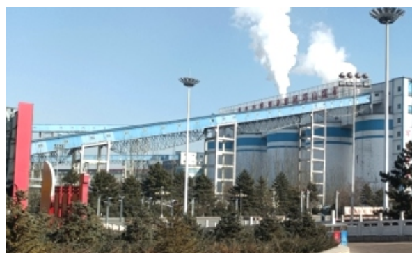
全封闭带式输送机走廊
