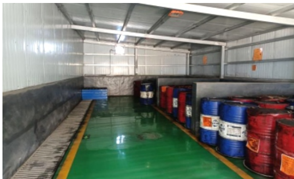
危废暂存间废矿物油暂存区
