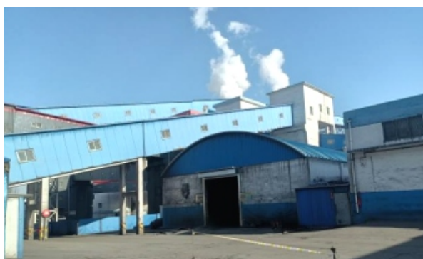
全封闭带式输送机走廊
