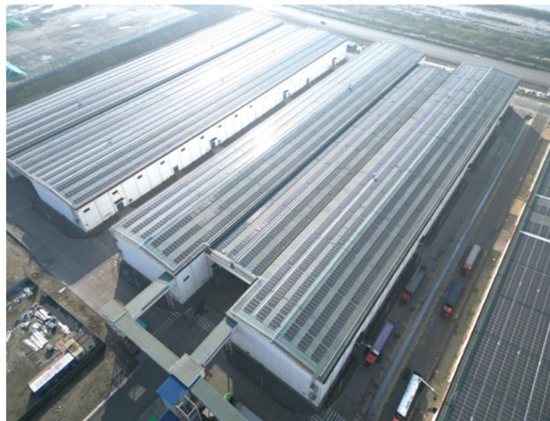
唐山糖业通过在厂区屋顶安装光伏板，利用太阳能发电替代传统能源，显著提升清洁能源的使用比例，并有效降低碳排放
