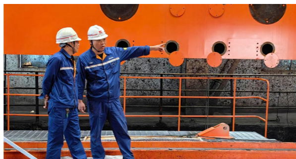
对重点设备日常巡检，排查隐患。
