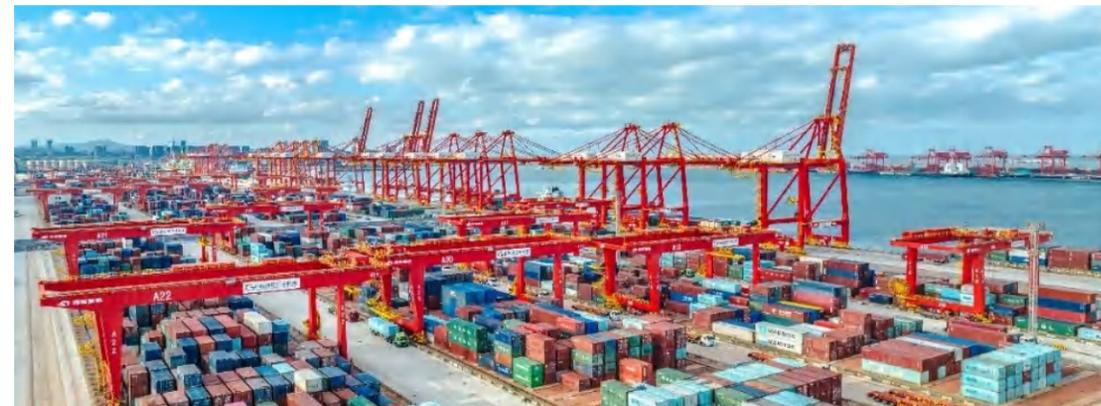
以“远控岸桥+自动化轨道吊+无人集卡”为布局，首创“顺岸布置边装卸+无人集卡水平运输”工艺，并率先运用“北斗+5G”技术。同时，自主研发集成无人集卡调度系统等6项国产化、业界首创科技成果，成功攻克无人集卡“去安全员”的世界级难题，实现核心生产系统全国产、全自主。
